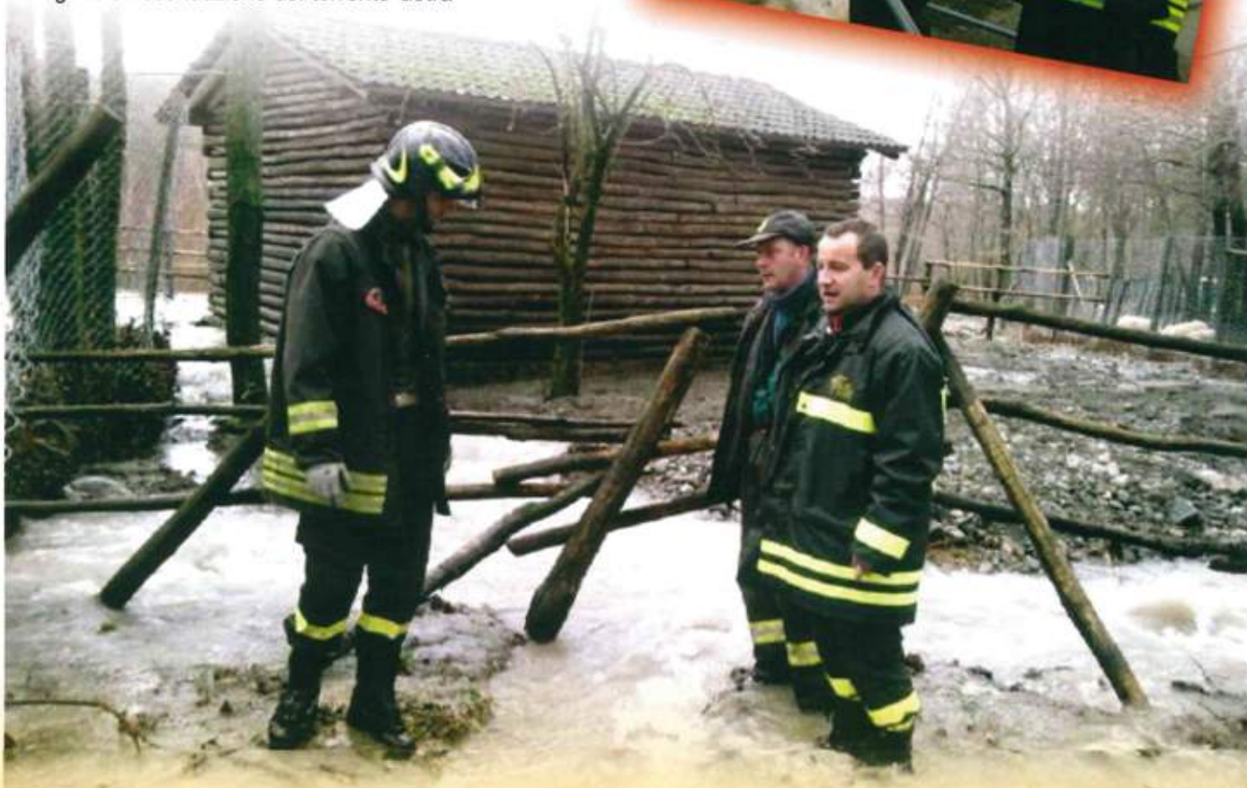
Verifica e sopralluogo della recinzione abbattuta di un allevamento di daini, crollata in seguito all'esondazione del torrente Gotra
